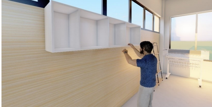
Gambar 10. Ilustrasi pengangkuran lemari
